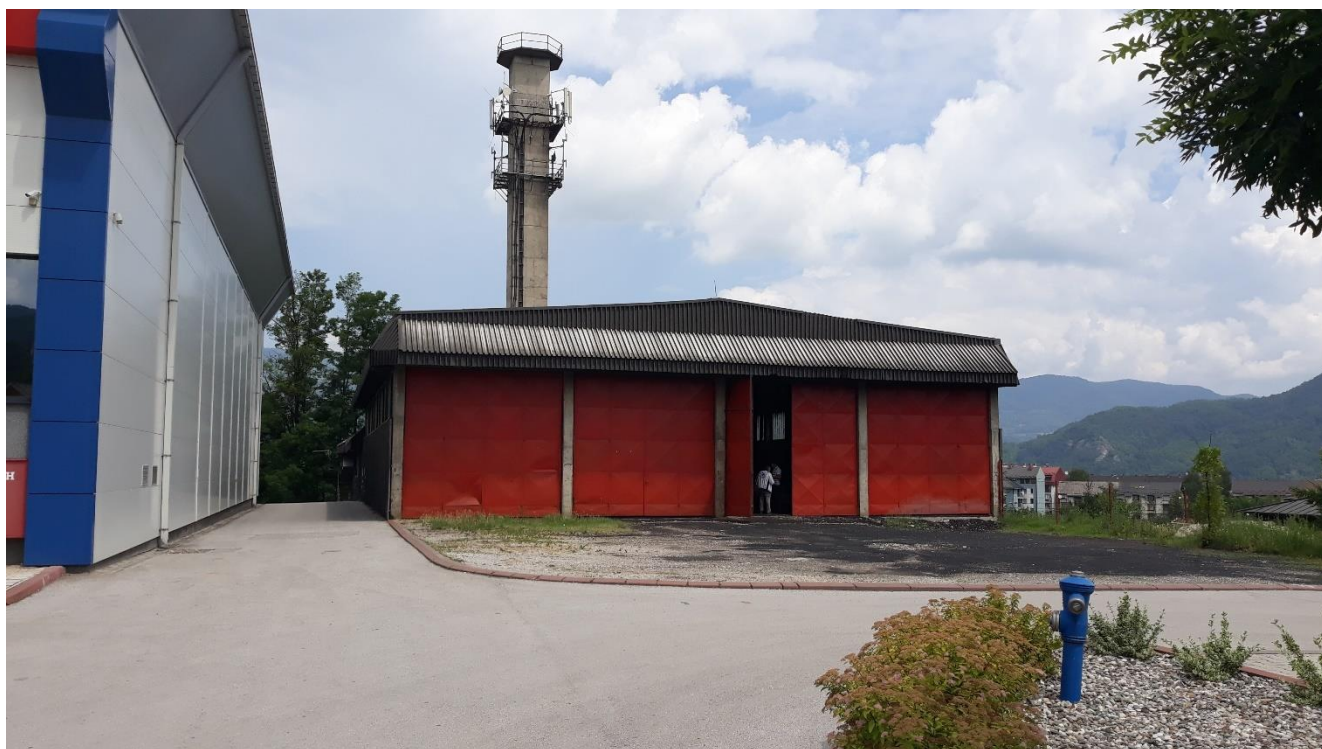
Слика 1 – постојећа котларница на угаљ
